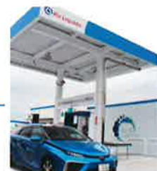
福岡宮田水素ステーション (宮若市上有木)
